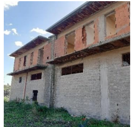
Figura 15 - Edificio A con forati di laterizio
