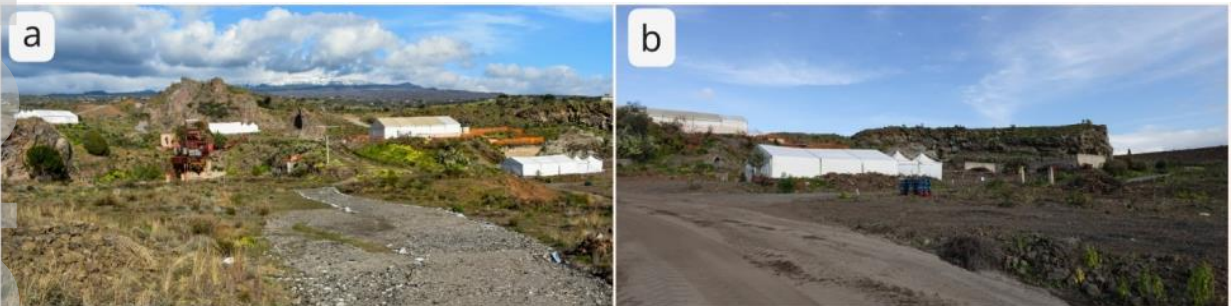
Figure 11 a, b - Viste dell'area del cantiere con le tendostrutture
