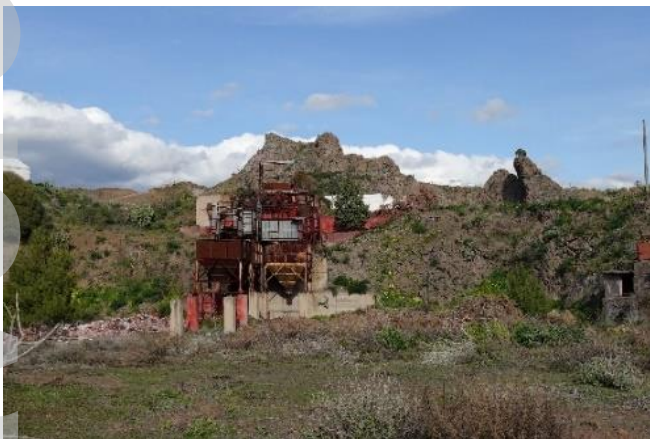
Figura 14 - Vecchio impianto di frantumazione
