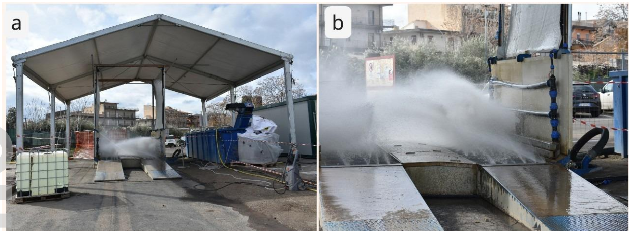
Figure 13 a, b - Stazione di lavaggio dei mezzi
