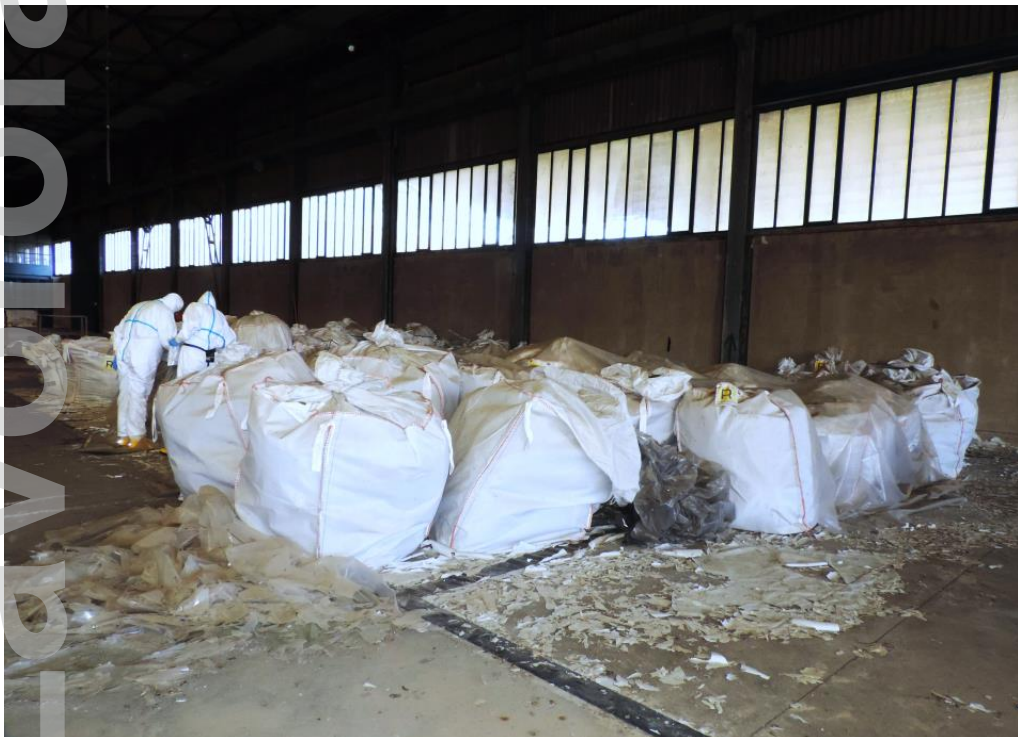
Figura 3. Preparazione di rifiuti contenenti amianto in big-bags
