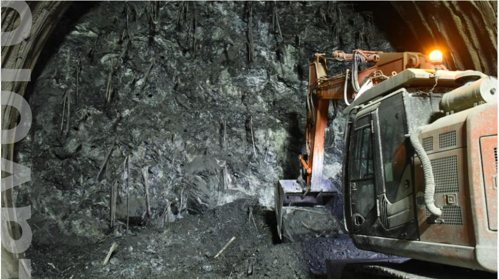
Figura 10. Scavo in Pietre verdi di un tunnel ferroviario
